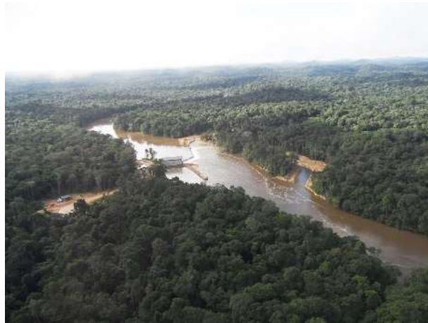
Centrale hydroélectrique- Source : VOLTALIA
